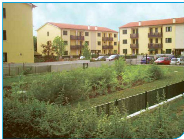
Impianto a servizio di una lottizzazione artigianale
