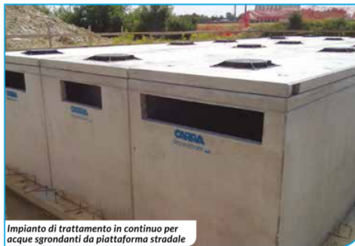
Impianto di prima pioggia con disoleatore in ambito autostradale
