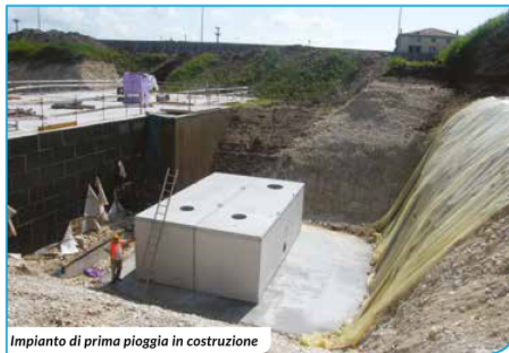
Impianto di trattamento in continuo per acque sgrondanti da piattaforma stradale
