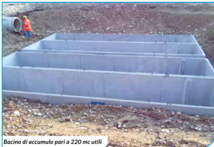
Impianto di prima pioggia con disoleatore in ambito autostradale
