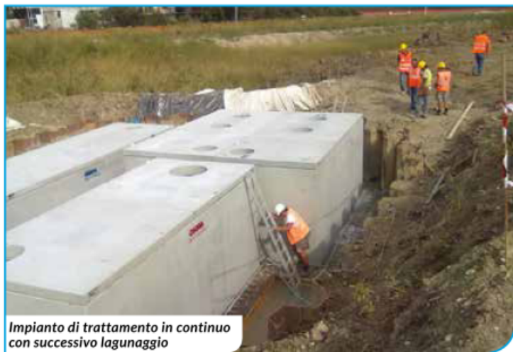
Impianto di trattamento in continuo per acque sgrondanti da piattaforma stradale
