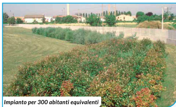
Impianto di affinamento reflui centro sportivo
