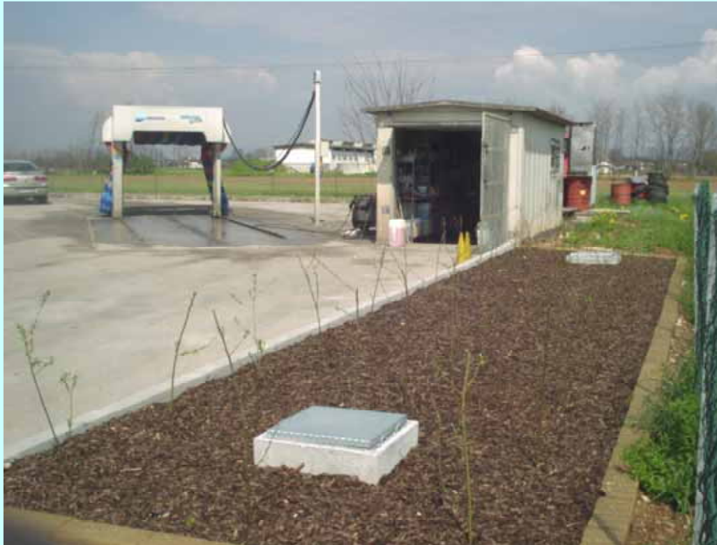
Impianto trattamento acque di prima pioggia presso stazione distribuzione carburanti
