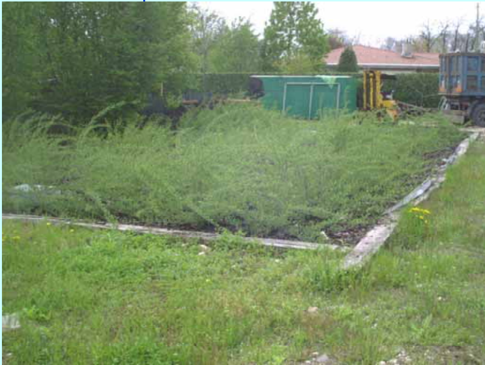
Impianto trattamento acque di prima pioggia presso stabilimento lavorazione materiali ferrosi
