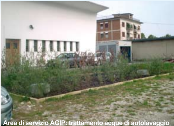
Area di servizio AGIP: trattamento acque di autolavaggio
