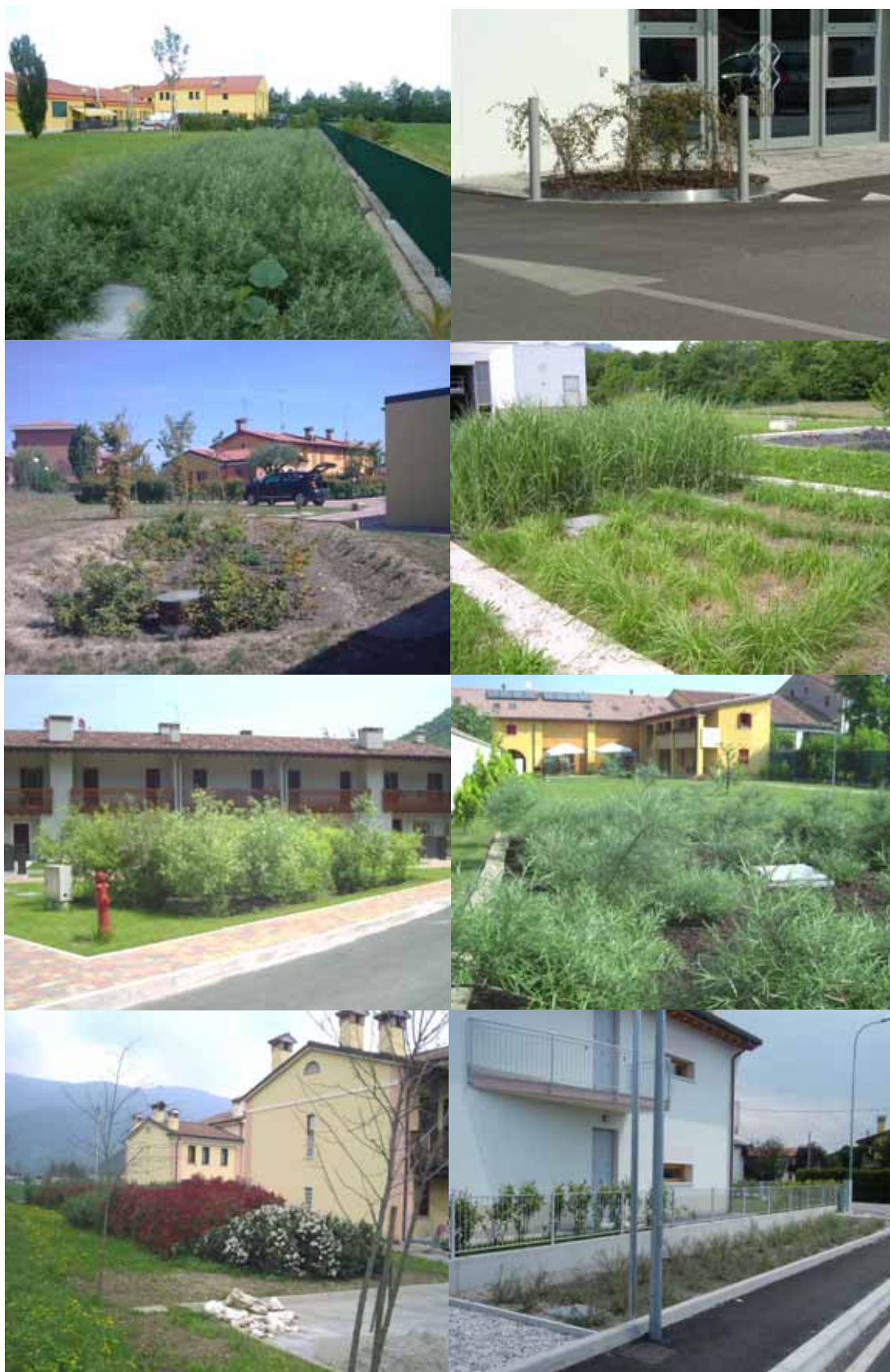
Alcuni esempi di realizzazione di impianti a flusso verticale da noi progettati e costruiti.
