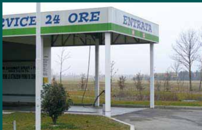
Stazione di servizio carburanti: trattamento acque di autolavaggio
