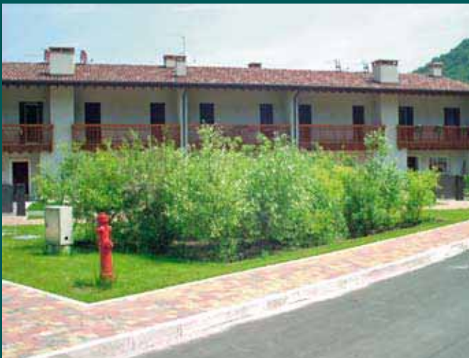
Impianto per 40 abitanti equivalenti
