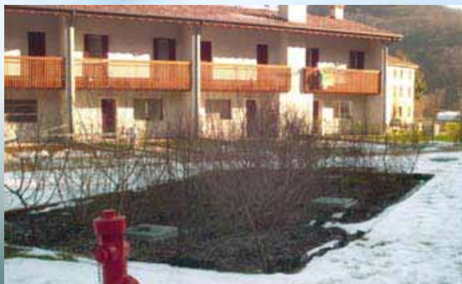
Impianto realizzato ad alta quota
