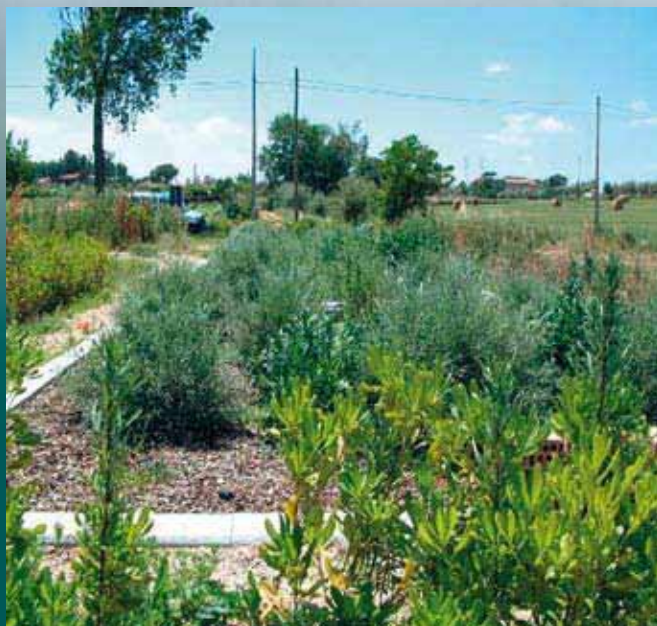
Impianto per 200 abitanti equivalenti
