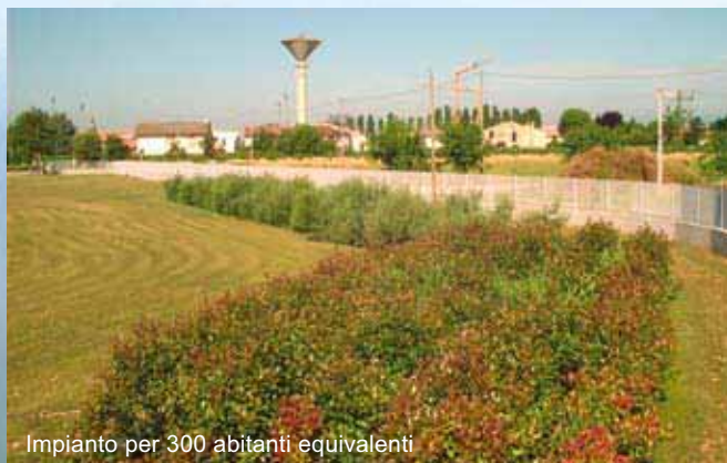
Impianto di affinamento reflui di centro sportivo
