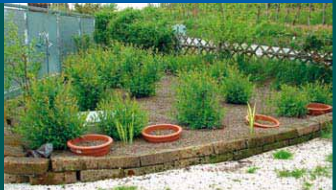
Trattamento reflui da cantina di vinificazione
