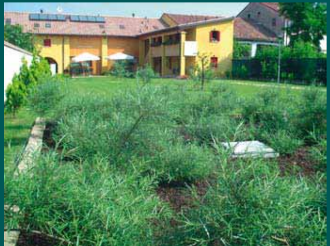
Impianto per 80 abitanti equivalenti
