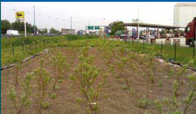
Trattamento acque meteoriche di dilavamento da A.d.S. autostradale
